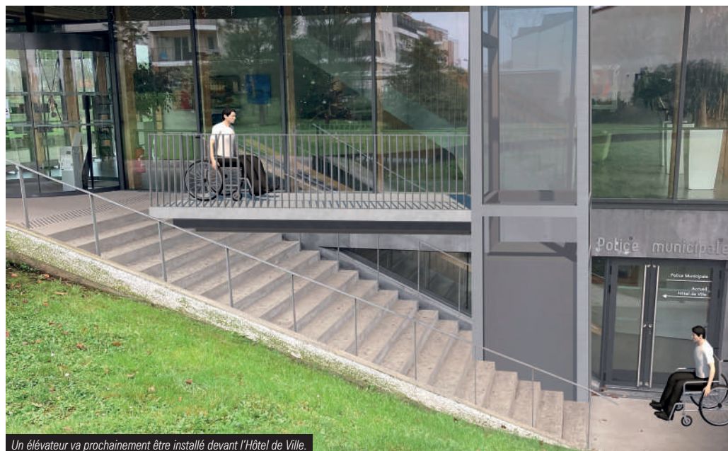
Un élévateur va prochainement être installé devant l'Hôtel de Ville.
