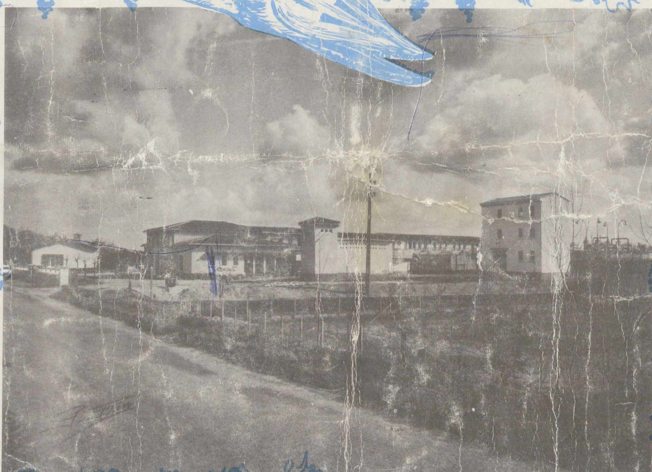
La station de pompage et de traitement des eaux du syndicat intercommunal du canton de Vertou. (Photo FREOR. La Montagne)
