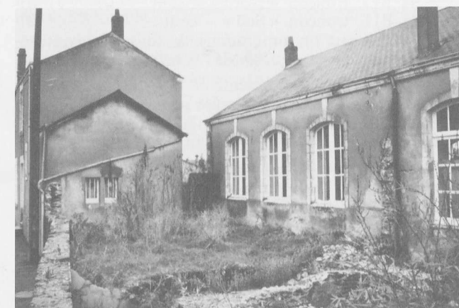
L'ancienne salle de classe (avant les travaux).
