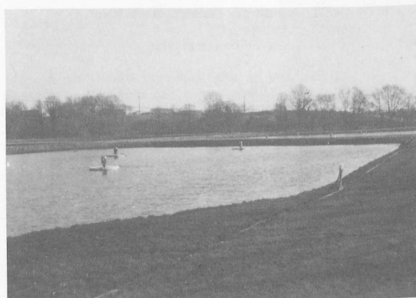
AOÛT : La Station d'épuration du Grignon est reliée à la Station de lagunage.
