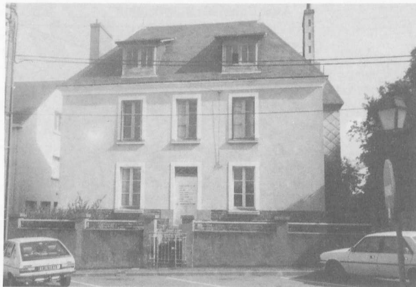
NOVEMBRE : La Maison «De Queral» va bientôt laisser place à 26 logements H.L.M. réservés en priorité au 3ème âge.
