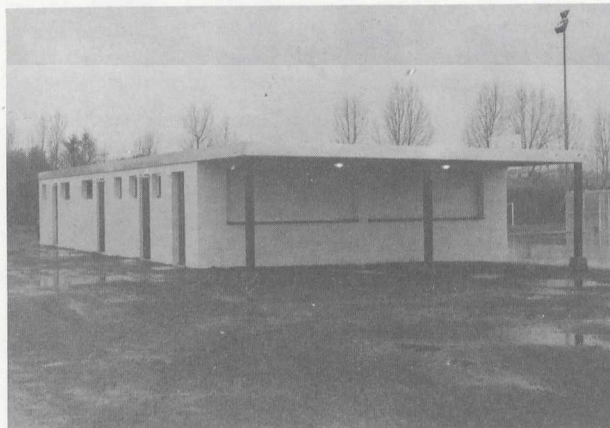
Vestiaires sportifs terrain du Grignon. Utilisés par le Club de Football.
