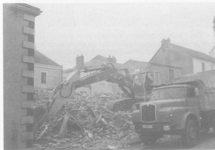
Démolition de bâtiments vétustes dans le Centre Bourg.
