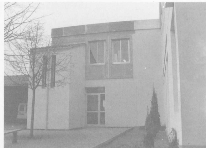
Construction de 2 nouvelles classes.
