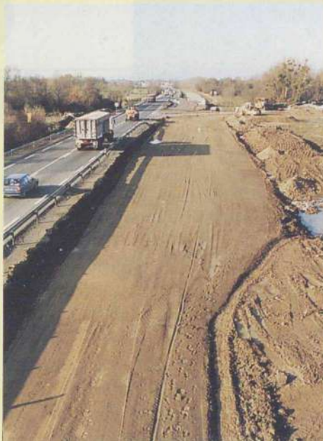
Travaux sur la RN 249
