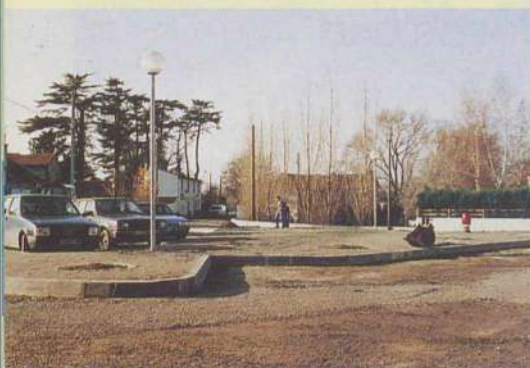
Travaux Place de la Rivière
