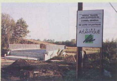
Pont de l'Arche en construction
