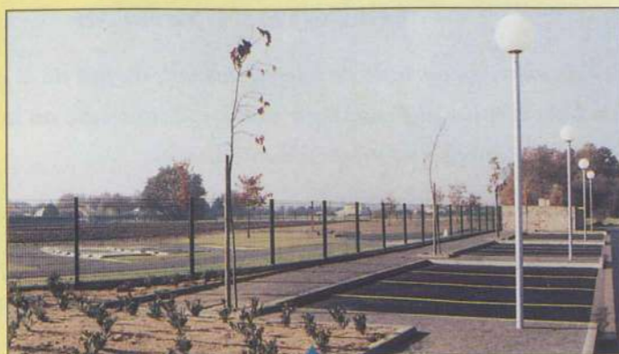
Deux parkings ont été créés accompagnés d'espaces verts et d'éclairage public : au nouveau cimetière, route des Landes de la Plée. Photo ci-dessus à l'école de la Champagnère "Les Tilleuls". Photo ci-dessous
