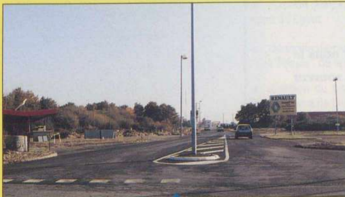
Rue de l'Atlantique (Pôle Sud) : une portion de voie a été réalisée
