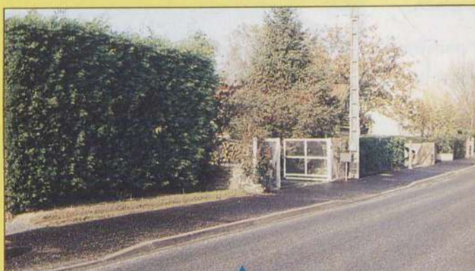
Ile Chaland : il a été réalisé des trottoirs dans le but d'améliorer la sécurité
