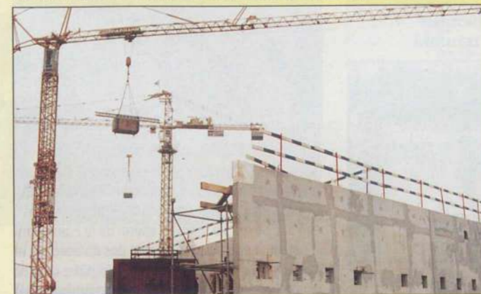
Le gros-oeuvre du collège en cours de réalisation
