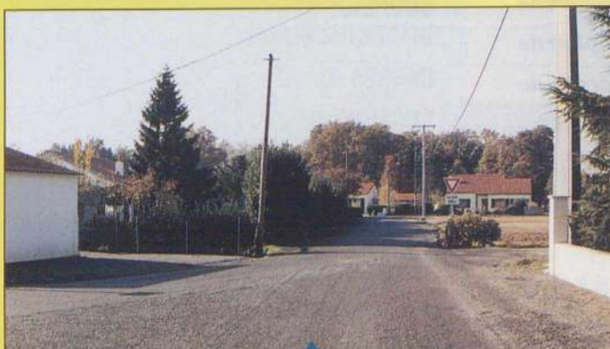
Rue de la Pépinière : une chaussée a été aménagée ainsi qu'en prolongement de la rue des Peupliers
