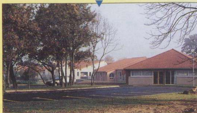
Rue de la Giraudière et au Bois Brûlé : le réseau d'éclairage public est installé.
