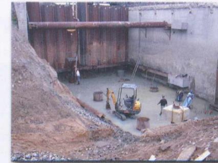
La solution technique retenue est le doublement de la station par l'adjonction de pompes en symétrie par rapport aux premières avec un rejet d'eau sur le côté droit. Cette solution présente plusieurs avantages : intégration dans l'environnement, plan d'eau du port conservé, manutention à partir de la route de desserte, coût de la construction moindre.
