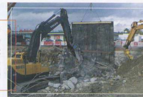
Début du remblaiement de la route passant sous la RN149 coté Basse-Goulaine
